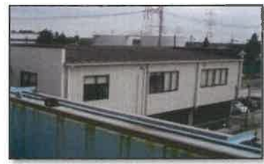
写真2 未塗装の建屋
